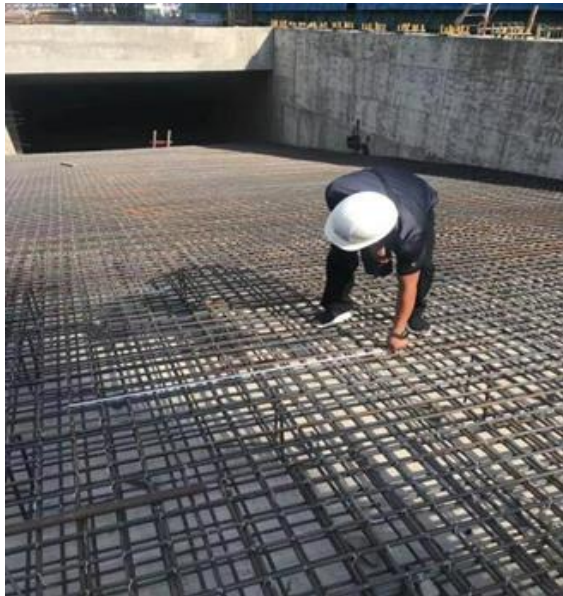
汽车坡道筏板钢筋绑扎
