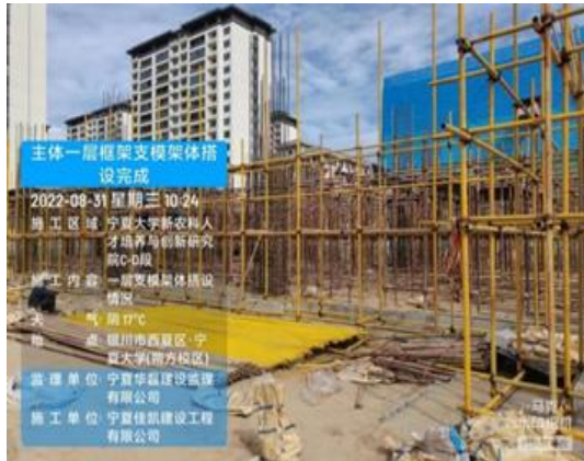
主体一层框架结构支模架体搭设
