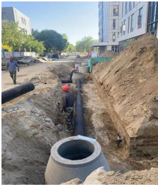
污水管道安装
