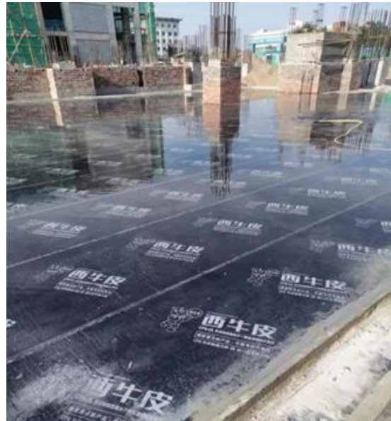
A段南侧地库顶板防水施工
