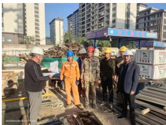
作业班组现场安全会
