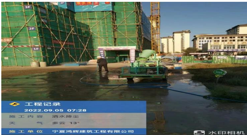
施工现场洒水降尘
