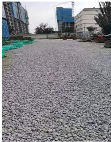
主道路铺设碎石
