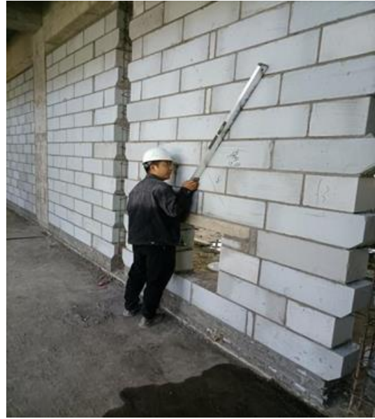
地库砌体砌筑
