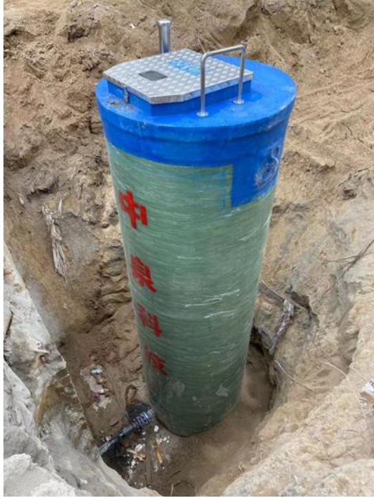
消防水池一体化泵站安装
