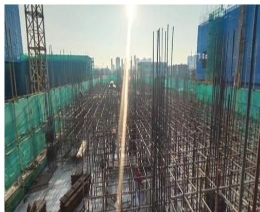
主体结构二层支模架体搭设施工
