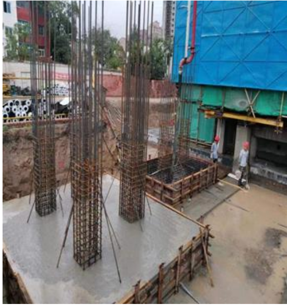
B段基础承台砼浇筑
