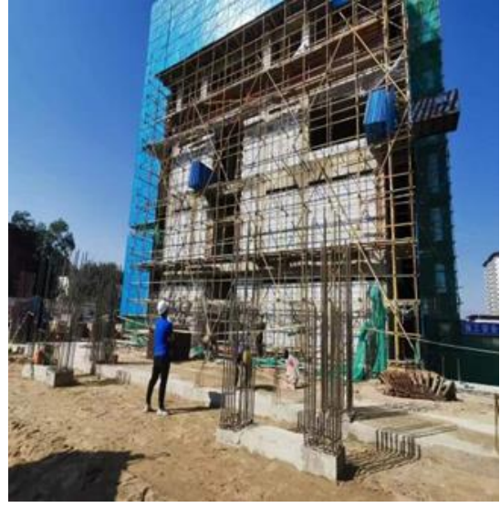
主体 3-6 层悬挑脚手架的搭设与钢板网的安装
