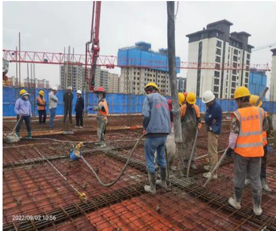
屋面混凝土浇筑施工
