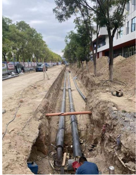
采暖管道安装
