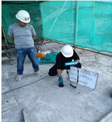
现浇楼板板厚检测
