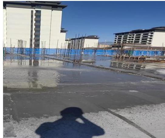
混凝土洒水养护
