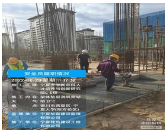
施工过程中安全员全过程监督
