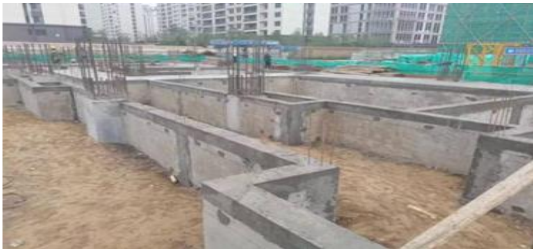
地沟墙体砌筑
