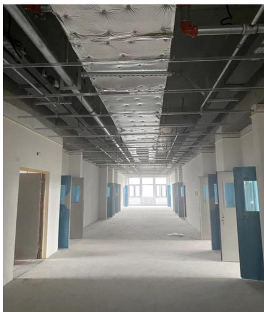
消防、通风管道，钢质门安装
