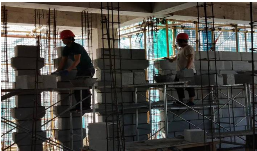
四层砌体砌筑施工
