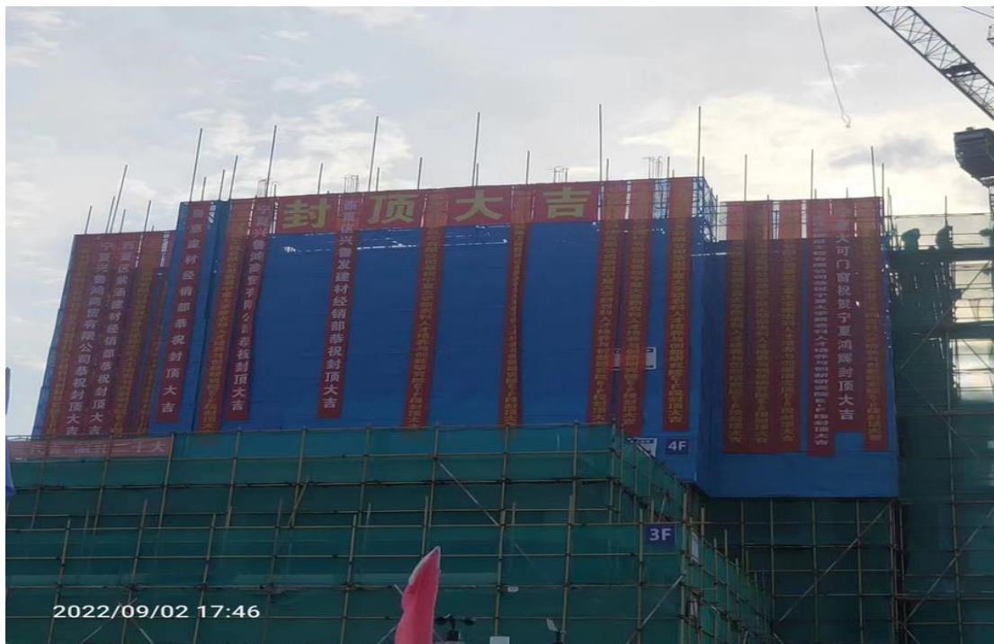
E 段六层主体封顶
