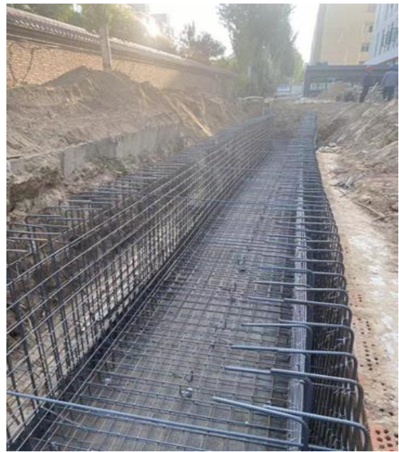
补水渠改造施工
