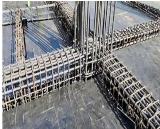
主体一层框梁钢筋绑扎
