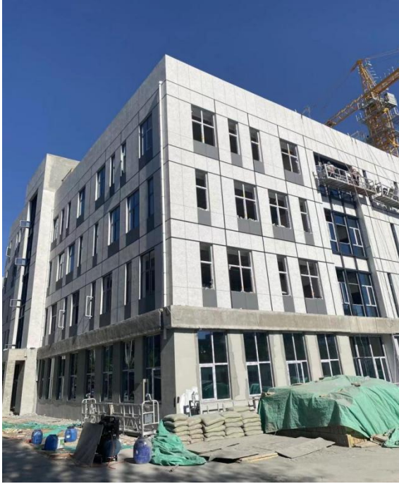
B区仿石漆施工
