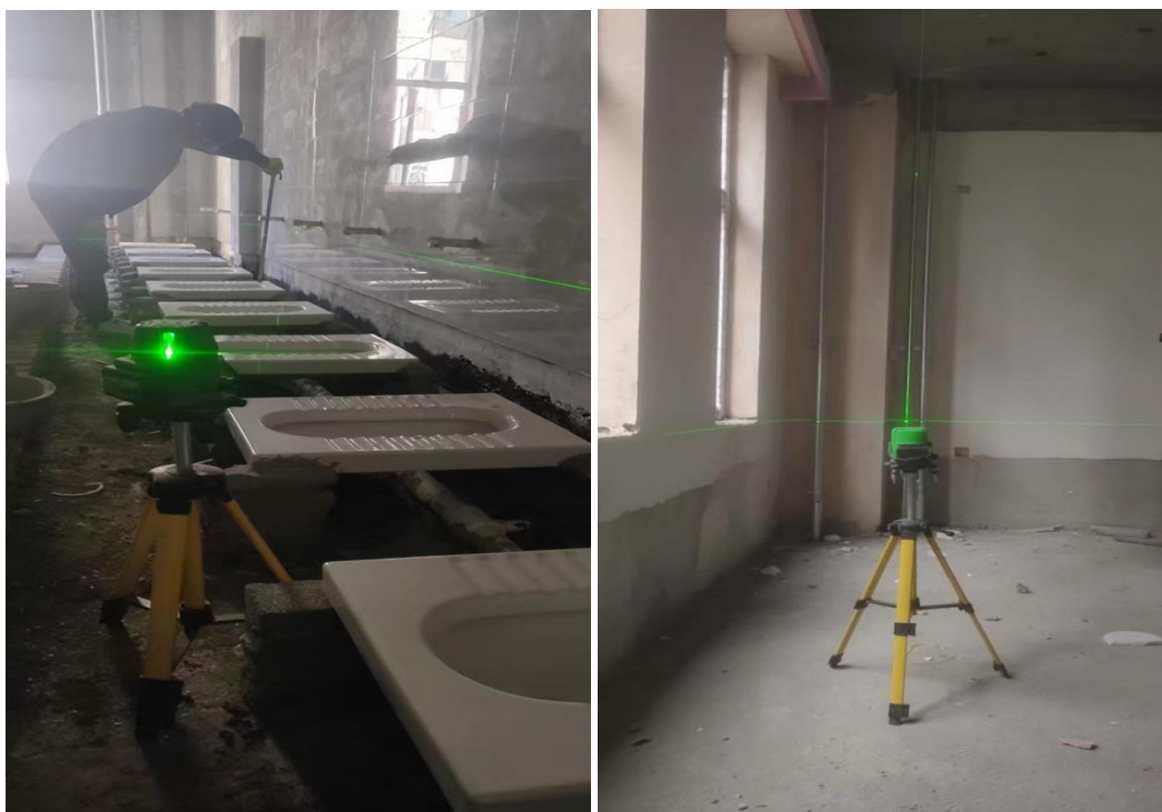
洁具安装、管道安装细部策划施工
