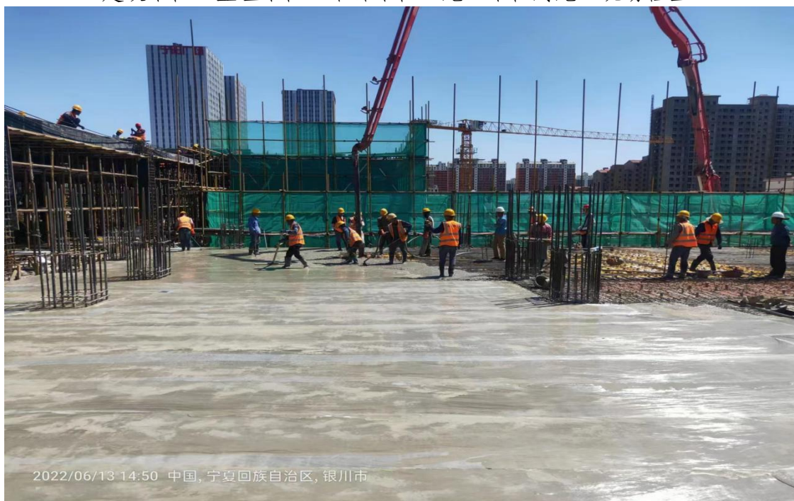
混凝土浇筑
