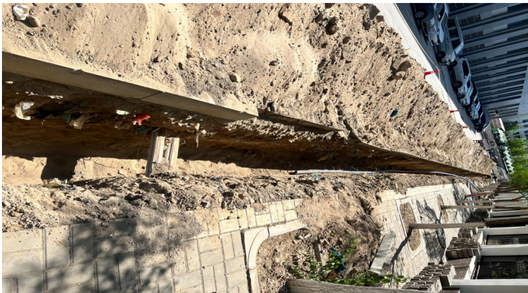
管沟土方开挖
