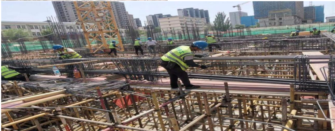
梁、板、剪力墙钢筋绑扎
