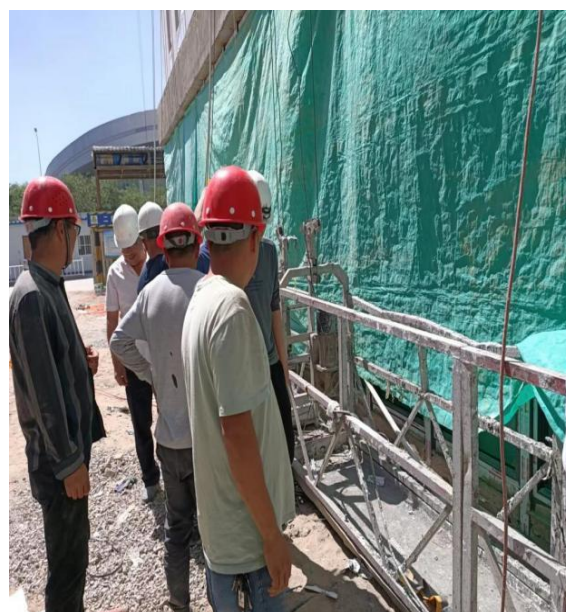
项目负责人实施安全检查
