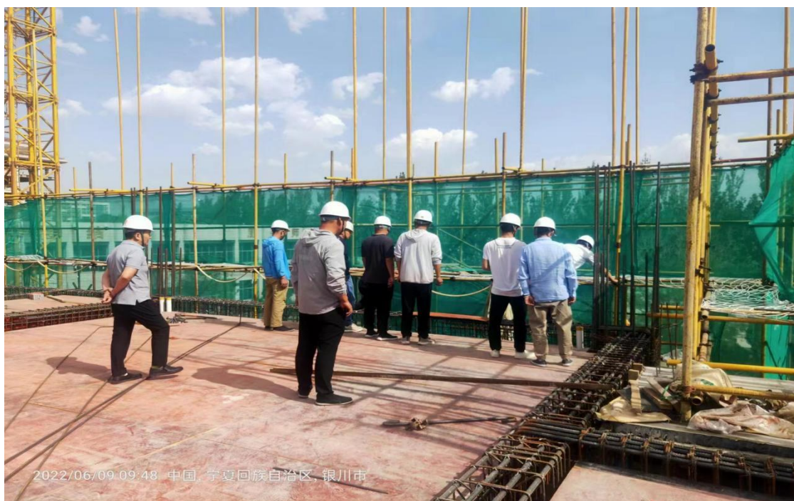
建设单位、监理单位、审计单位、施工单位对施工现场检查
