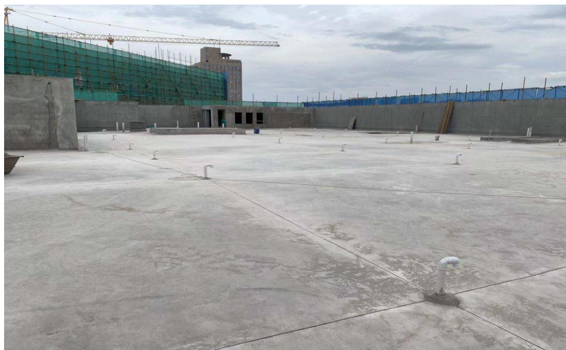
屋面找平层施工
