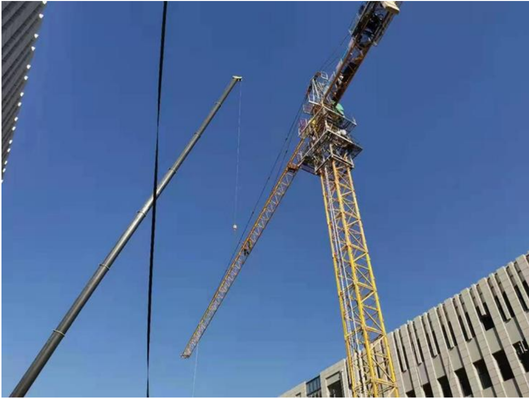
塔吊安全拆除
