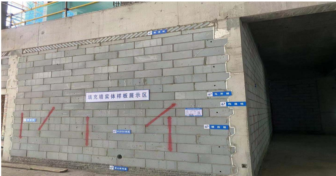
填充墙实体样板展示
