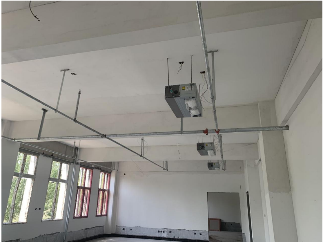
消防及喷淋管道安装
