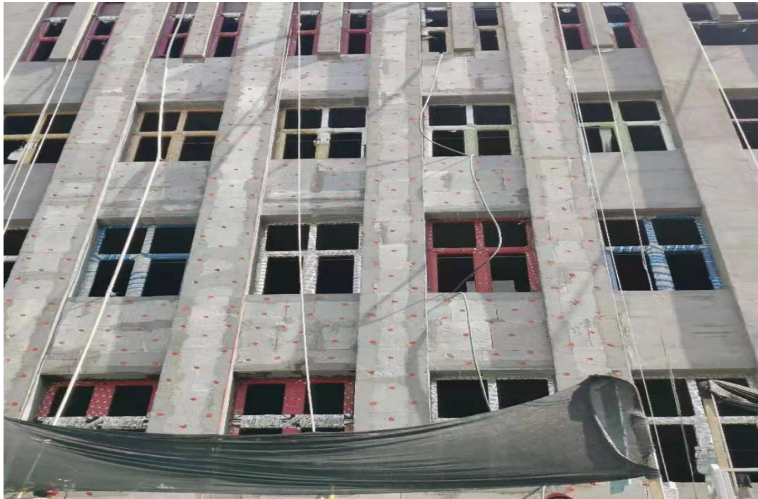
外墙保温施工
