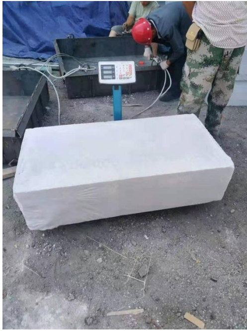
保温板容重现场检查
