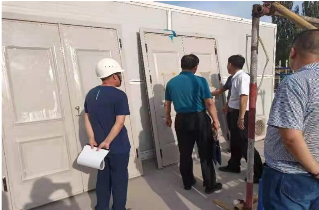
建设单位现场防火门样品查验
