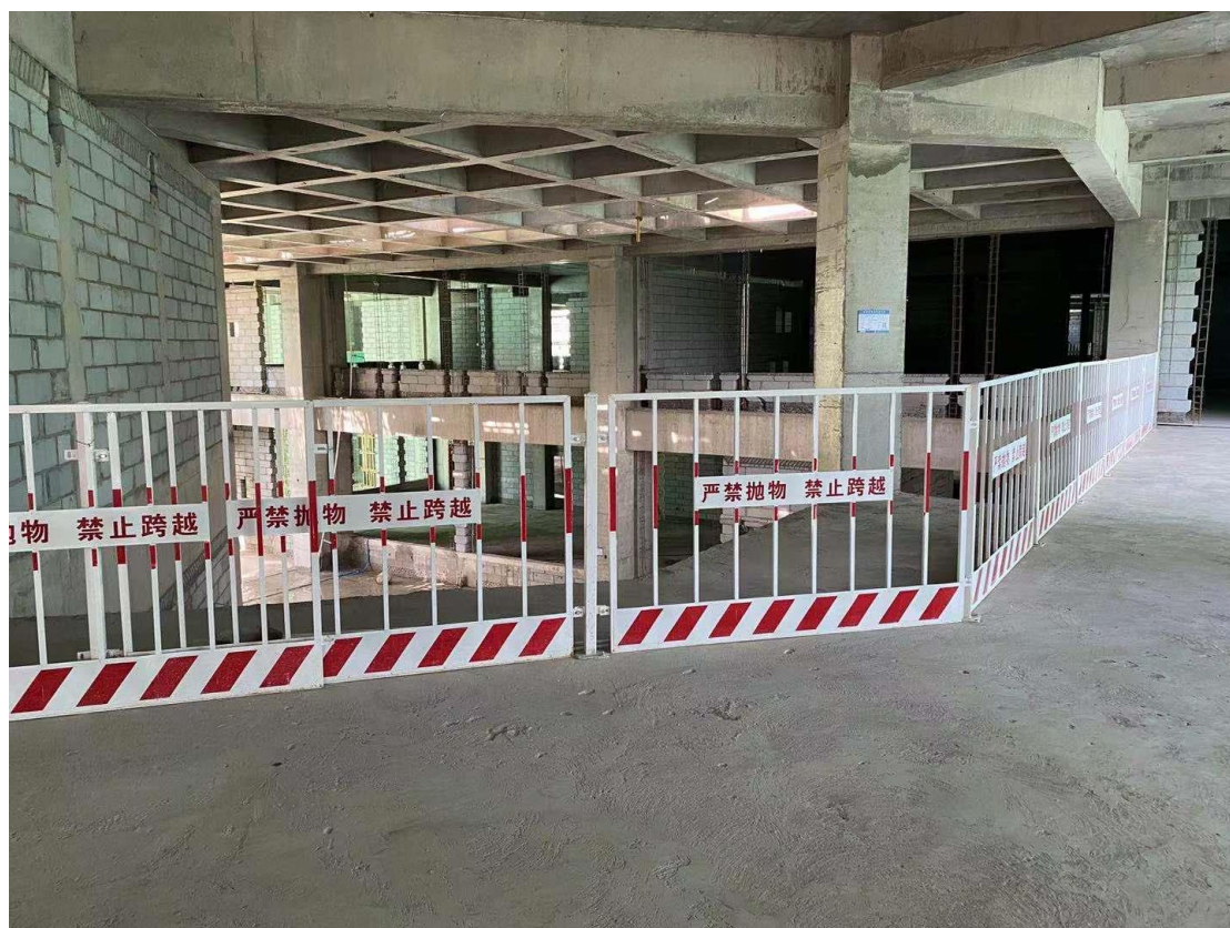
楼层临边防护
