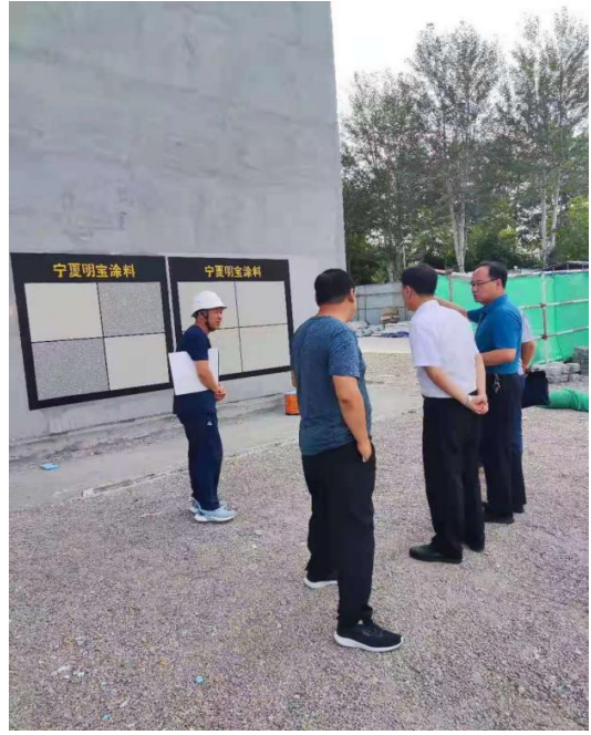
外墙真石漆样板查验
