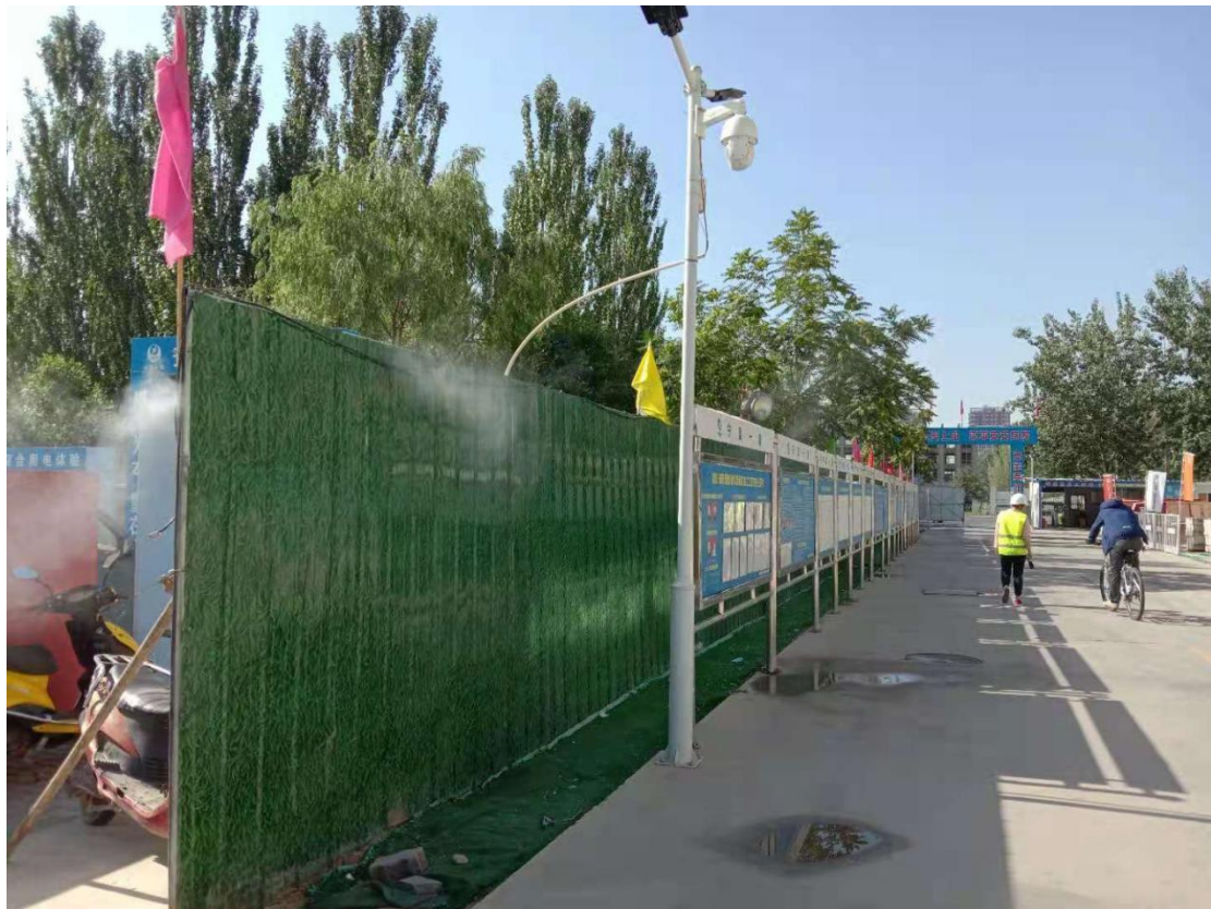
围挡喷雾自动定时开启，路面洒水降尘
