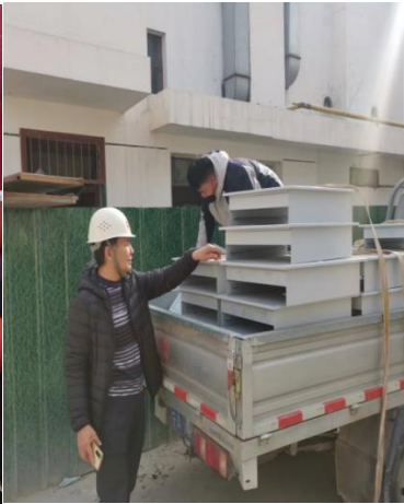
多媒体箱进场验收
