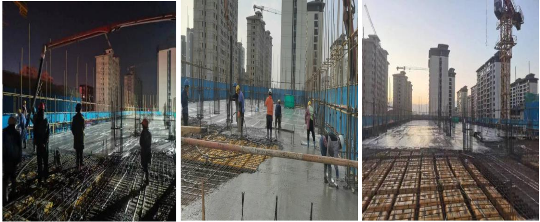
混凝土浇筑作业
