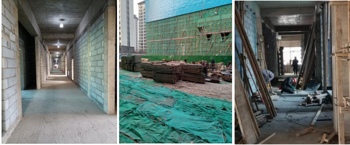
楼内场清、材料码放、主体及二次结构的模板、架体拆除
