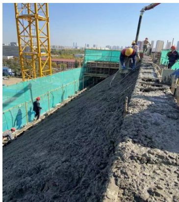
A 段屋顶层砼浇筑
