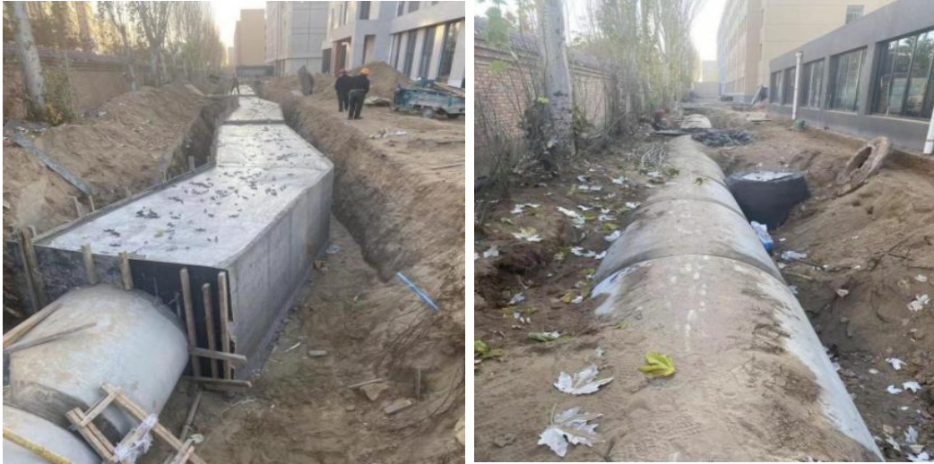
补水渠现浇、管涵施工
