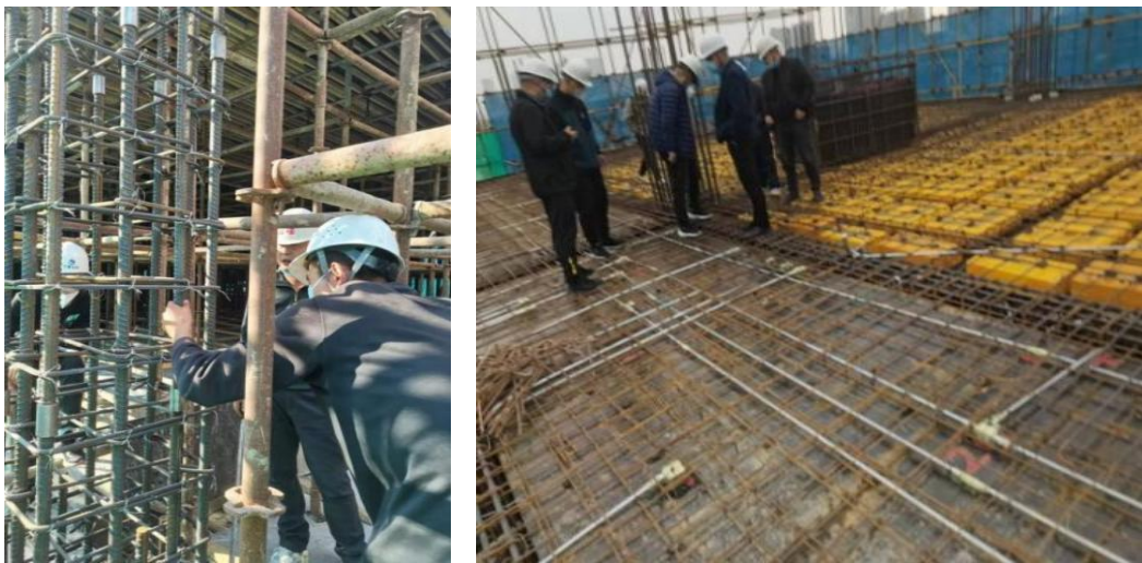
钢筋绑扎验收工作
