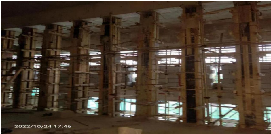
F 段门厅构造柱模板安装
