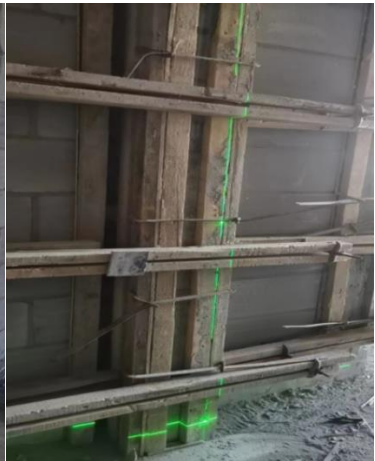
构造柱模板检查校正
