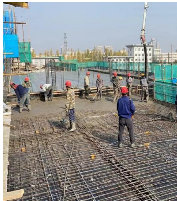
B 段屋面层砼浇筑
