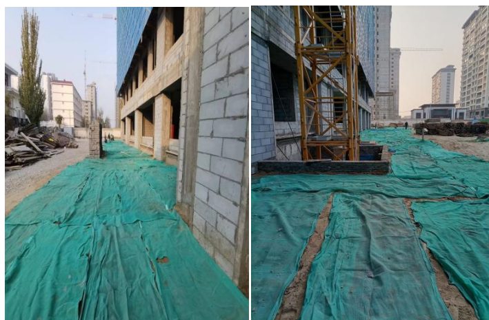
现场绿网覆盖裸土、塔吊周围砌筑挡墙
