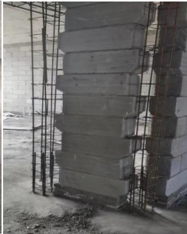
框梁与填充砌体封堵砌筑
