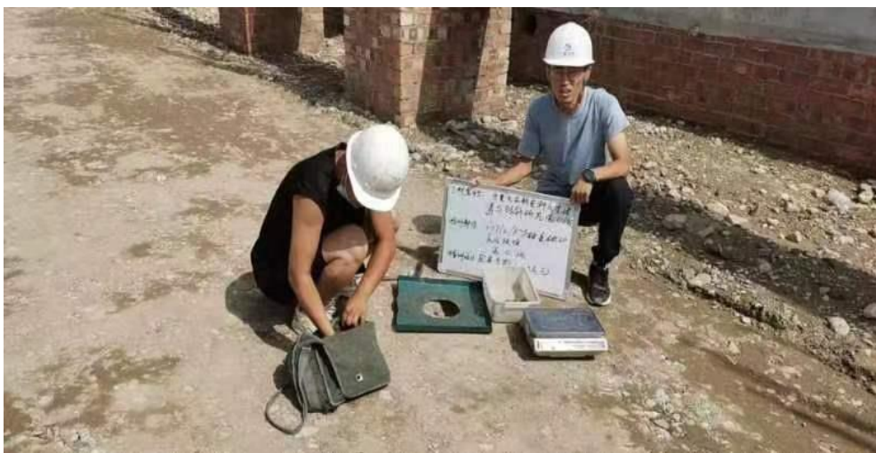
砂夹石压实度试验（常规检测）
