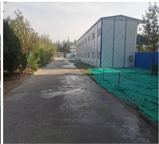
人工及喷淋系统的日常洒水降尘
