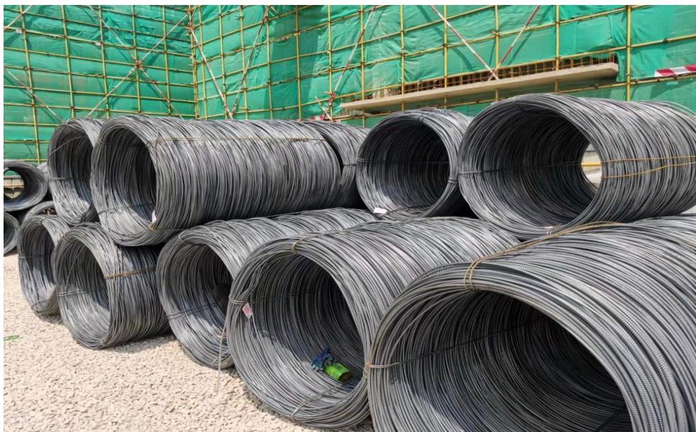
钢筋原材进场（盘螺）
