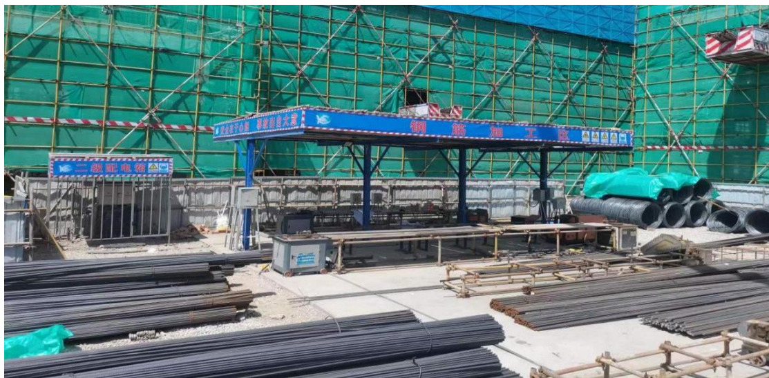
施工现场钢筋加工区
