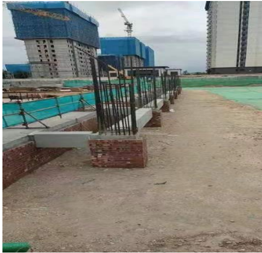
与 A-B 段相接处部位砂夹石回填完成
