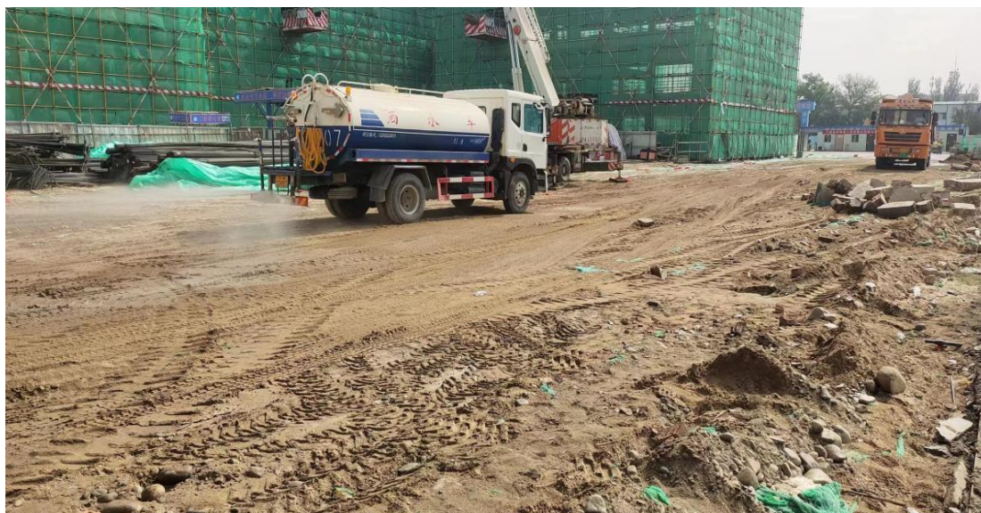
基坑开挖洒水降尘
