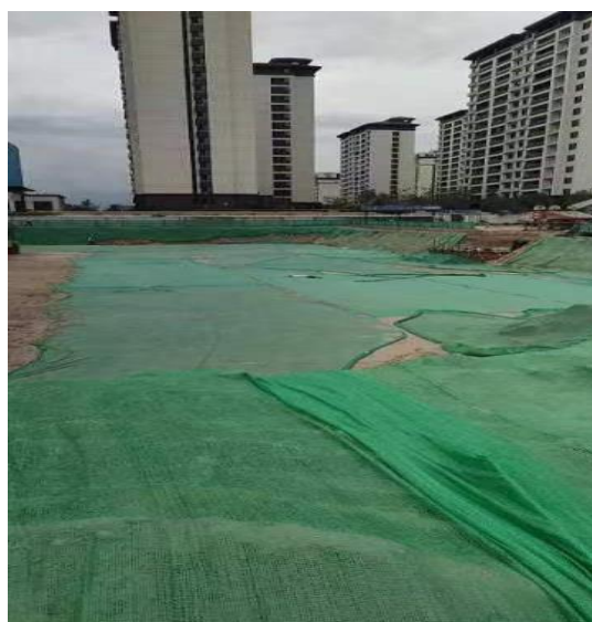
基坑开挖后的实际状态
