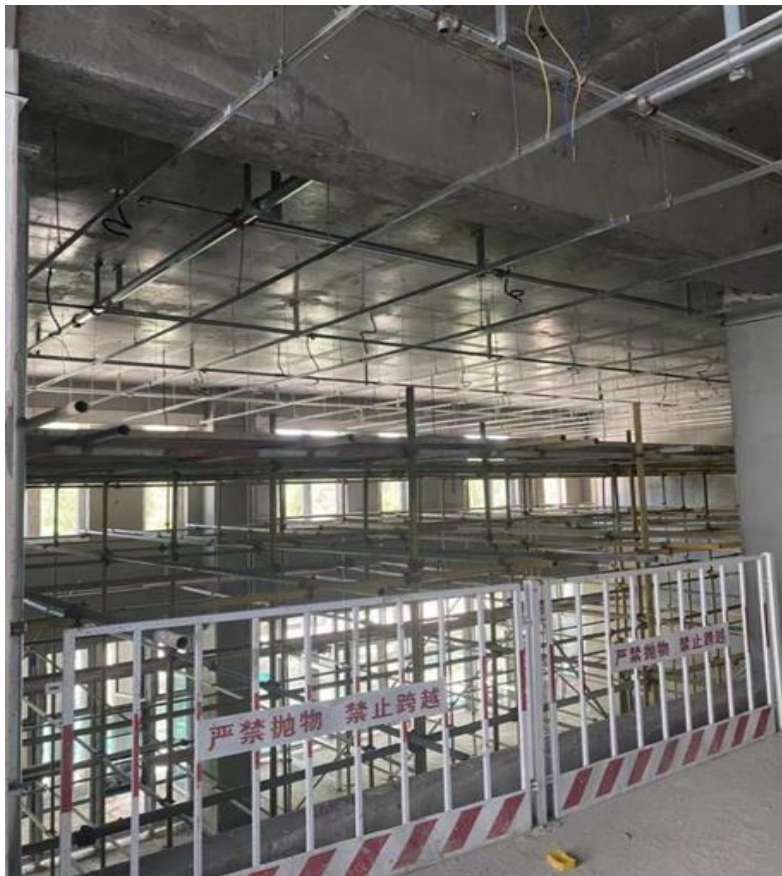
洞口临边定型化栏杆防护
