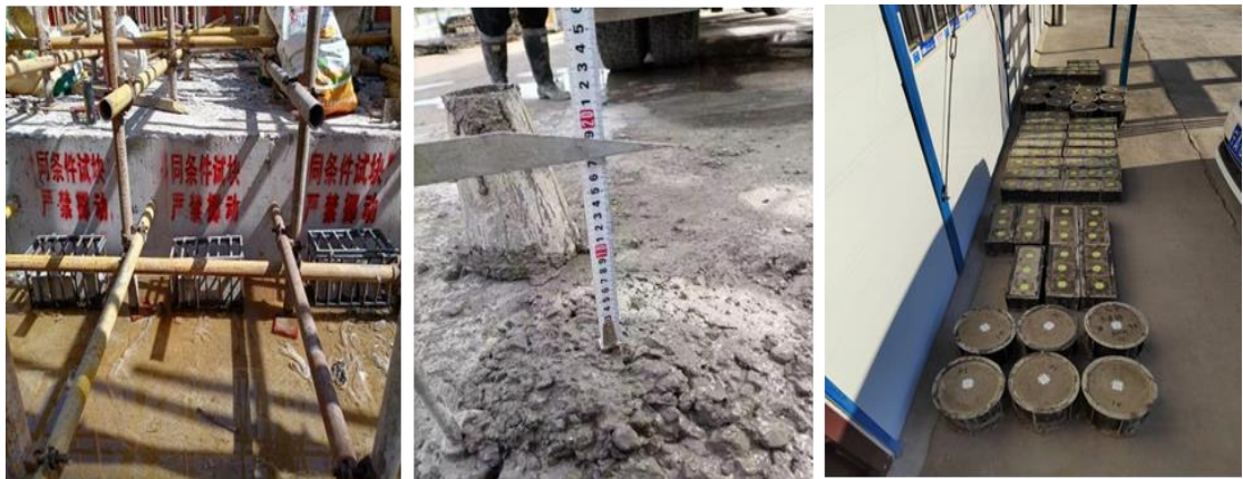
砼浇筑时坍落度检测和试块的留置
