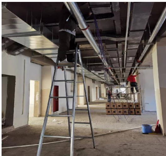
管线安装质量控制
