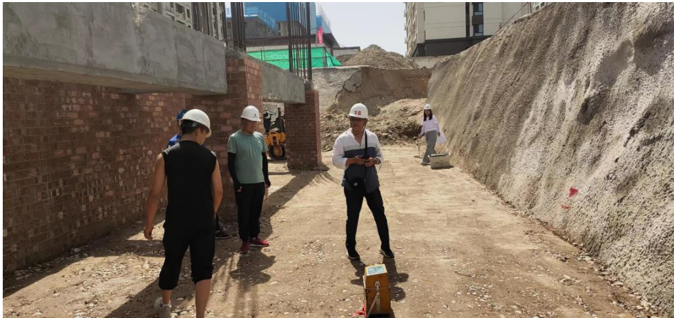
砂夹石压实度见证试验现场检测
