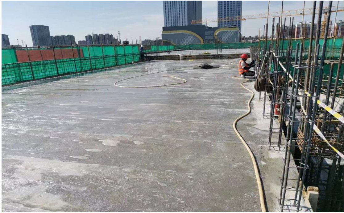
混凝土表面覆膜，并洒水养护
