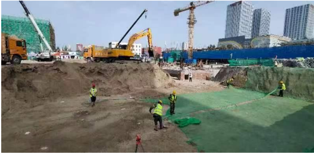
基坑土方开挖现场
