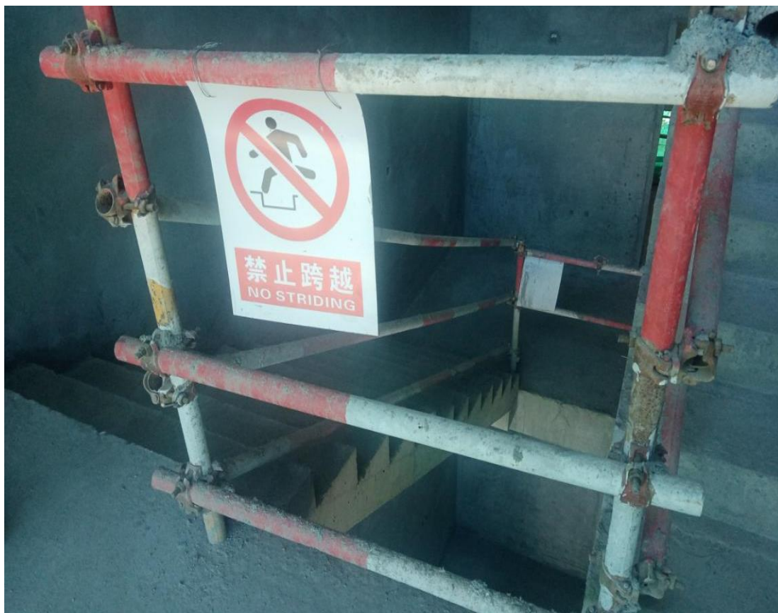
楼梯临边防护搭设
