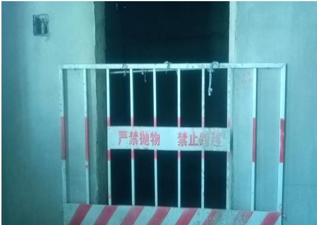
电梯井口固定防护搭设
