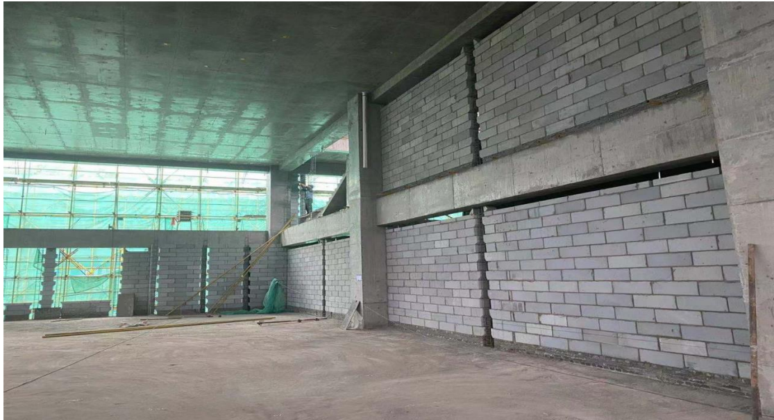
未来教室 4 段填充墙加气块砌体施工
