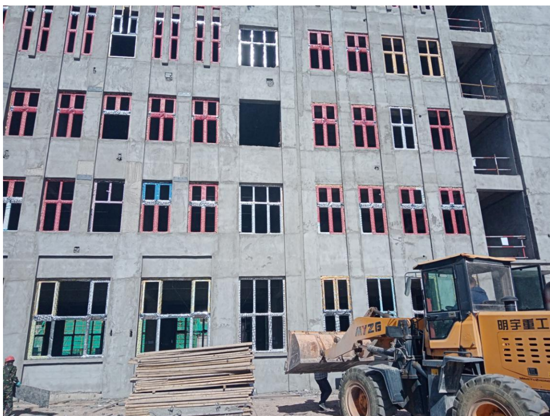
外墙抹灰工程
