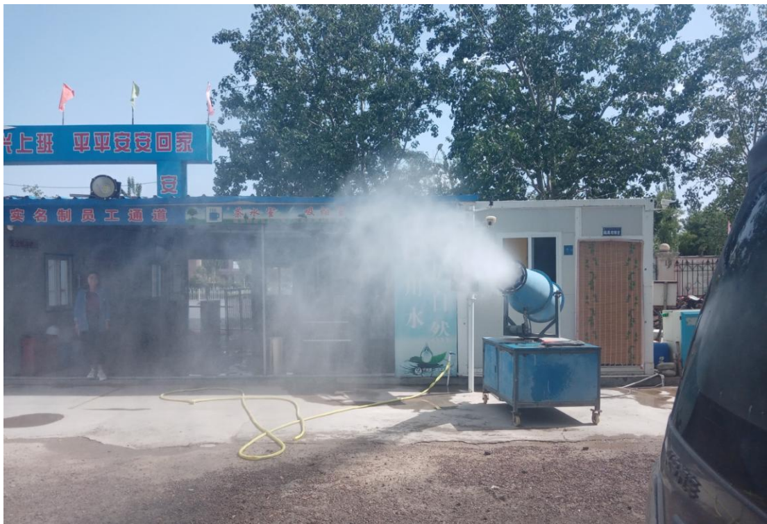
喷雾炮自动定时开启，路面洒水降尘
