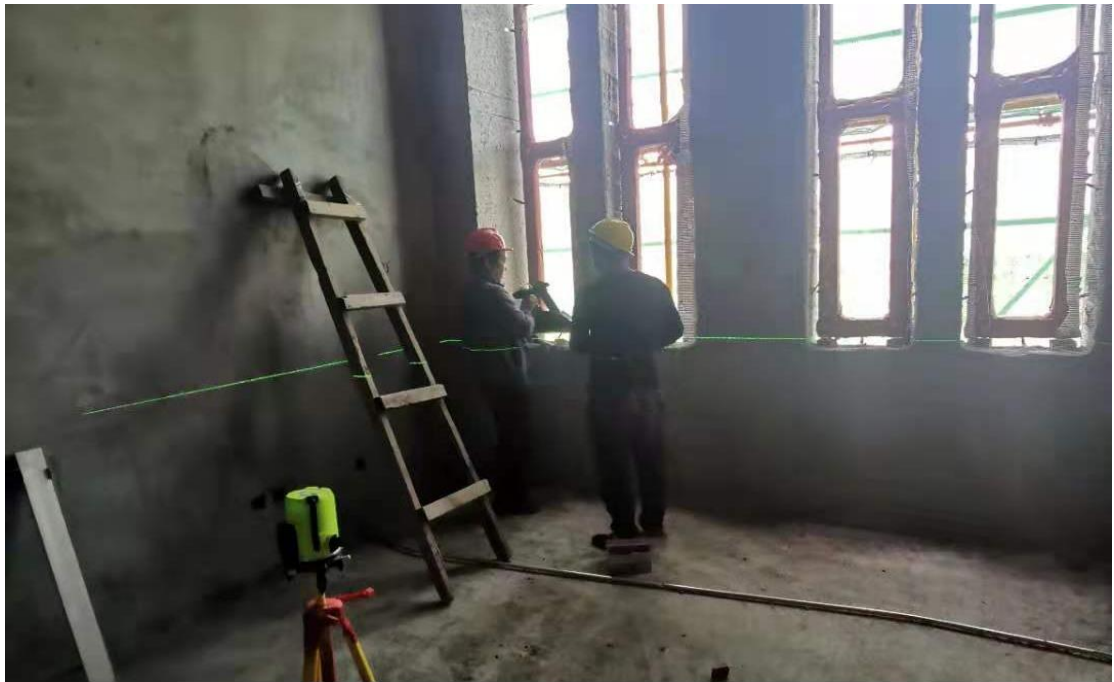
窗框安装控制水平度
