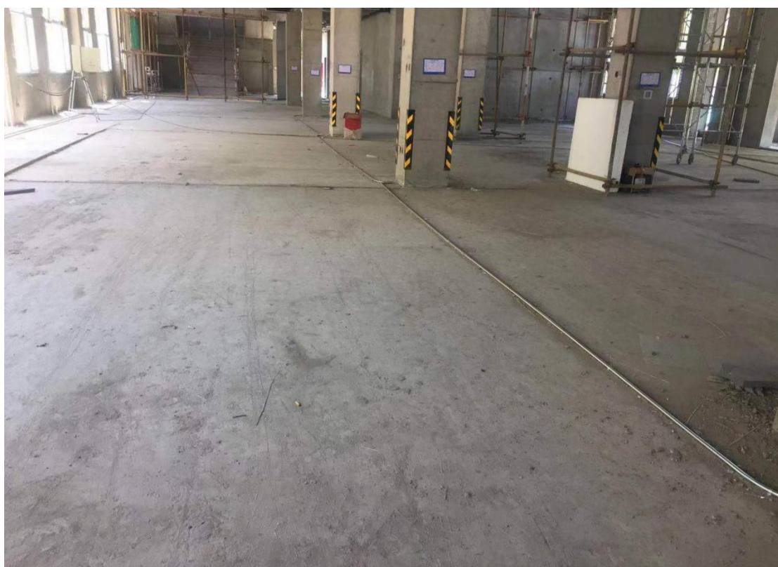
地面管线敷设
