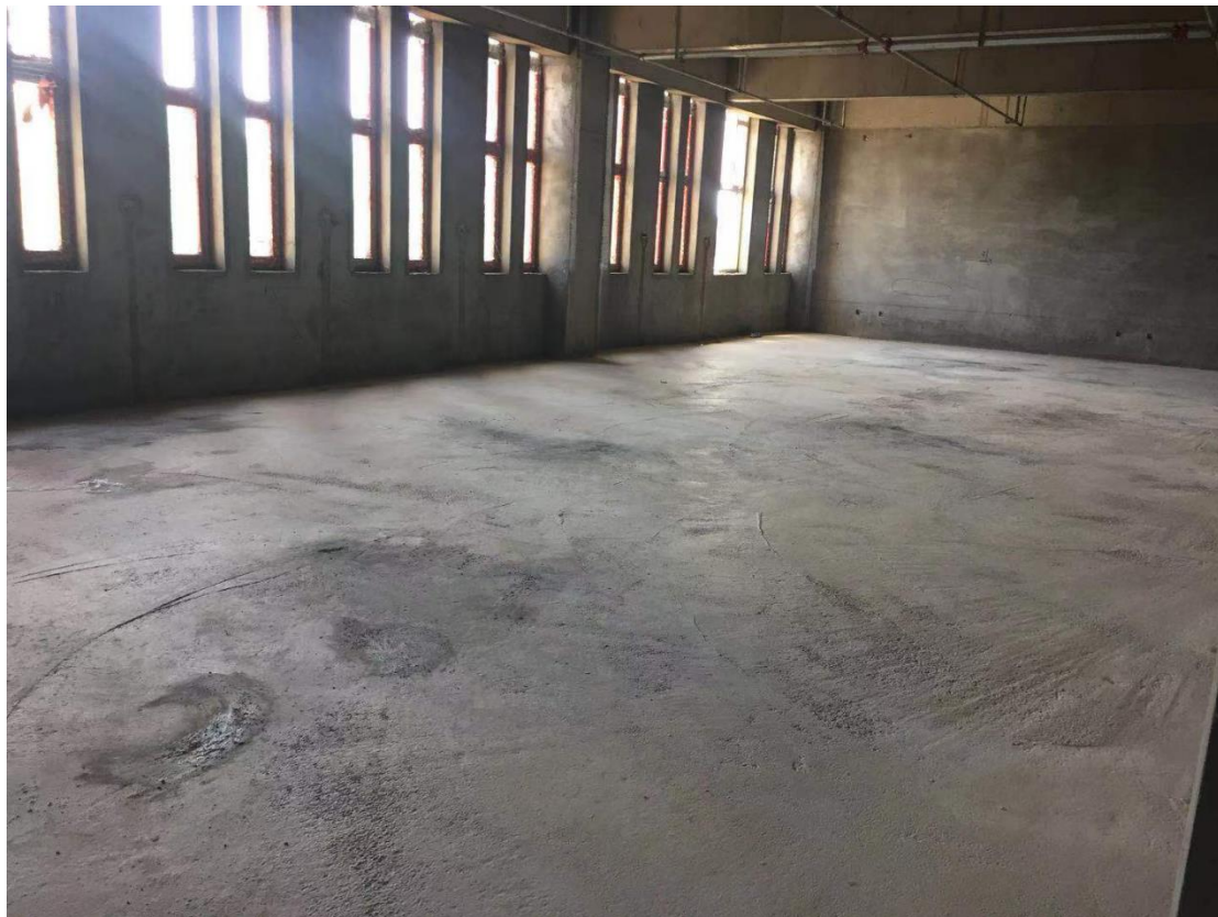
地面垫层及内墙抹灰
