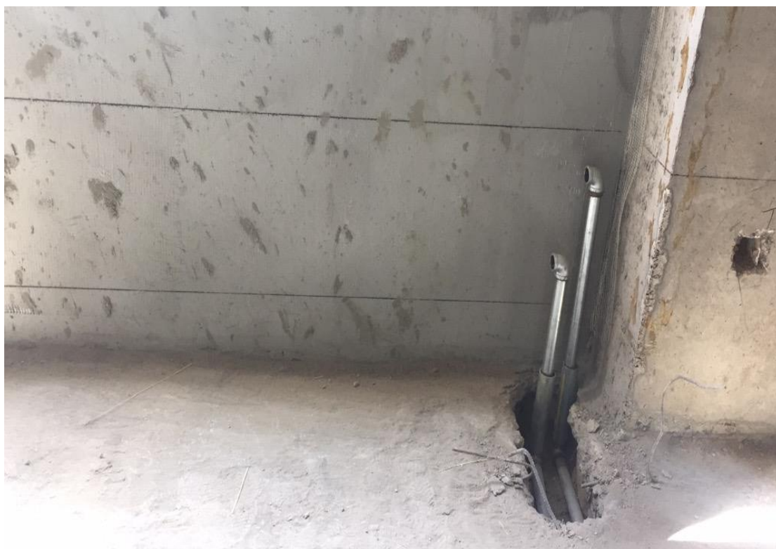
暖气管道安装
