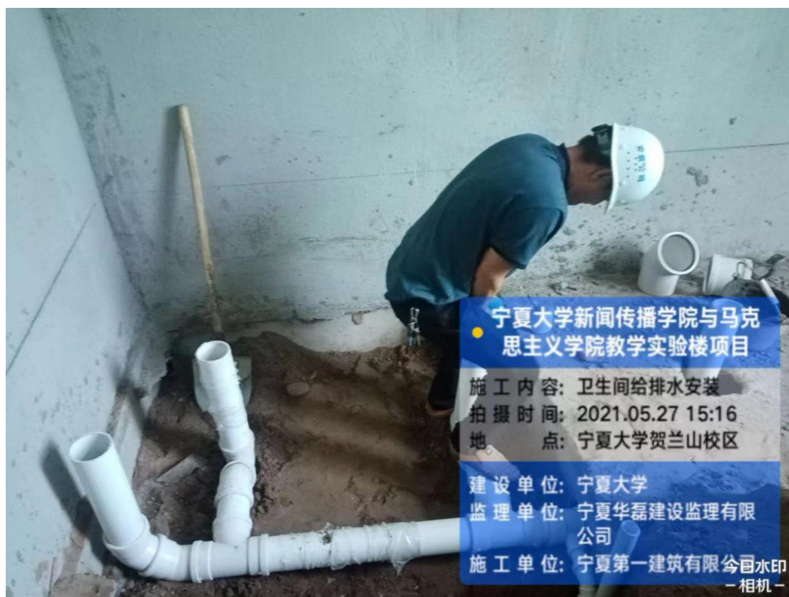
卫生间给排水管道安装
