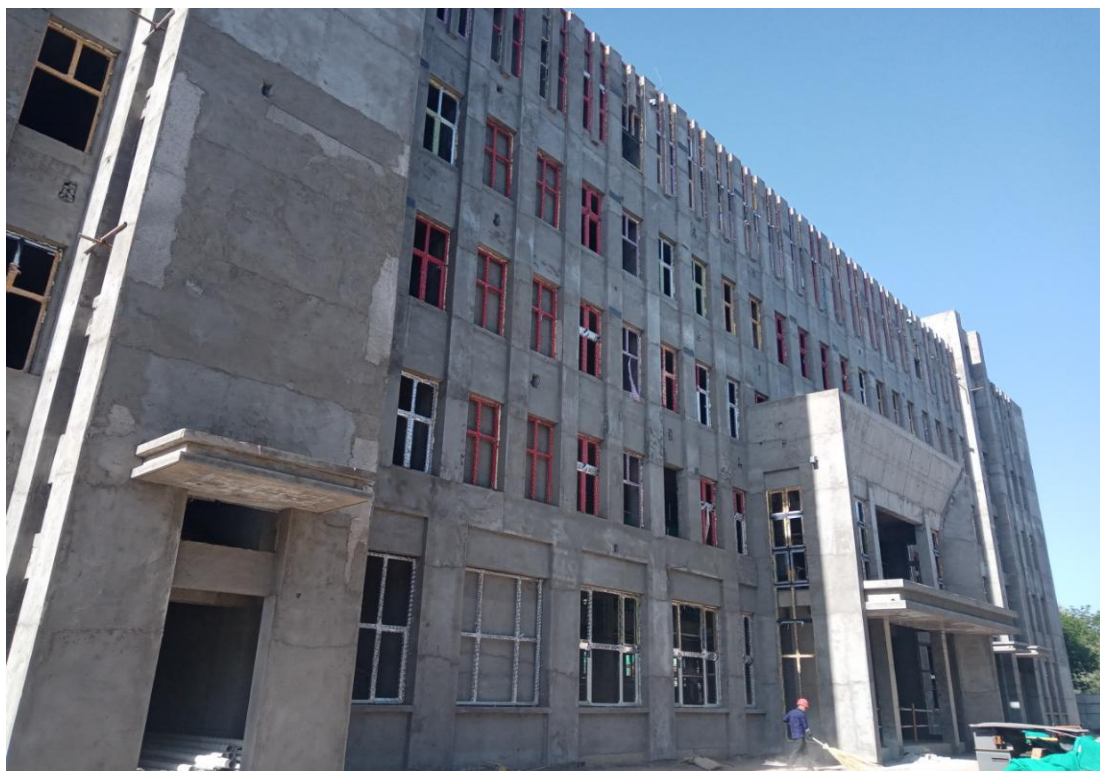
窗框安装完成
