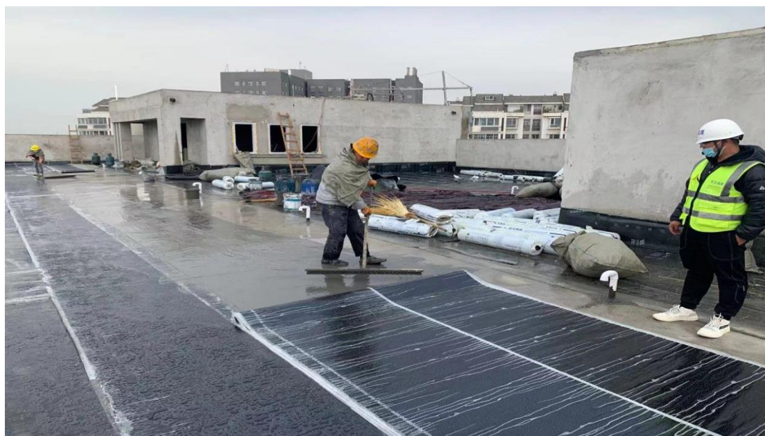
屋面防水施工
