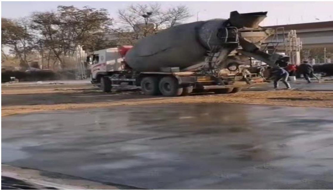
办公区、生活区场地平整及硬化
