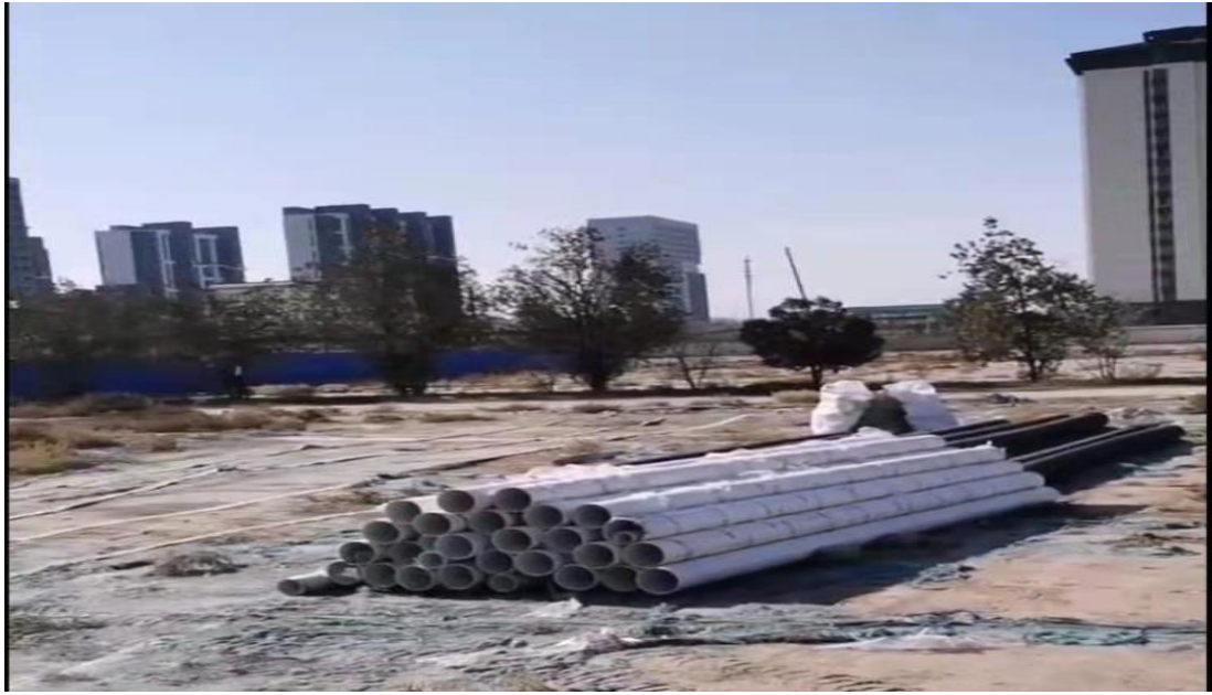
给排水管道铺设
