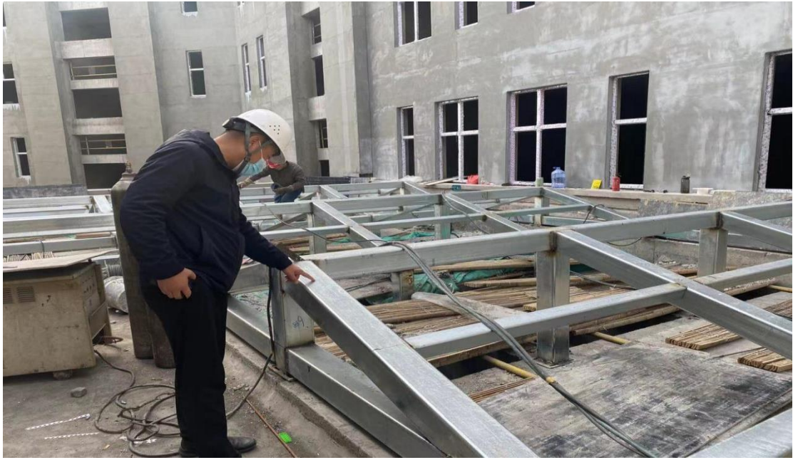
共享大厅采光顶钢骨架安装
