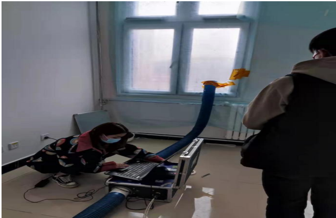
窗户现场气密性检查
