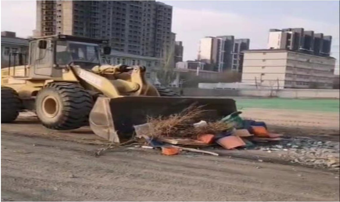
现场安全文明施工
