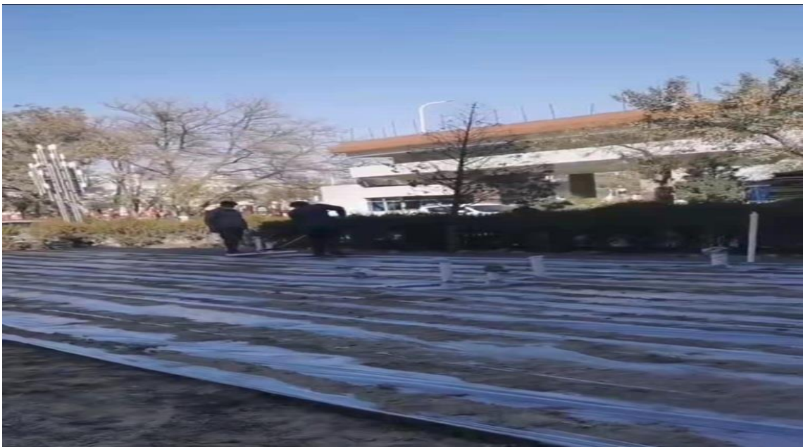
办公区、生活区砵场地养护
