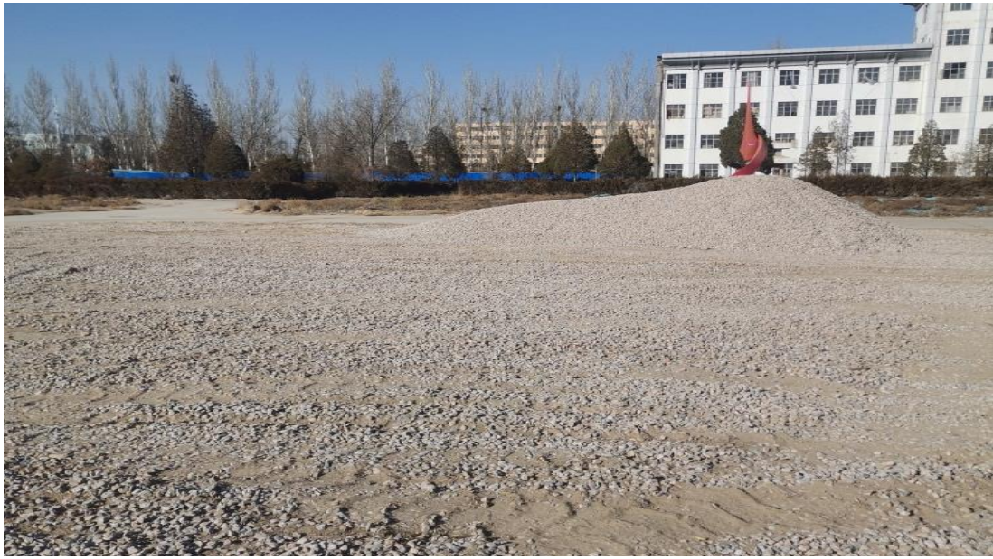
停车场整平及碎石铺设
